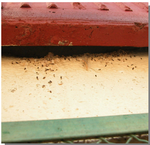
Murciélago de Cabrera: detalle de refugio en edificio
